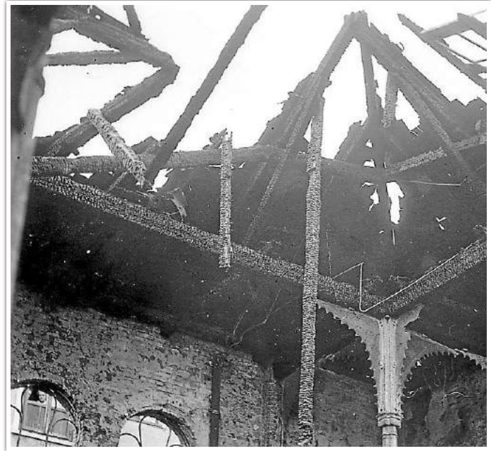
Die Kuppel der durch Brandstiftung zerstörten jeverschen Synagoge am 10. November 1938. BILD: ARCHIV HARTMUT PETERS
