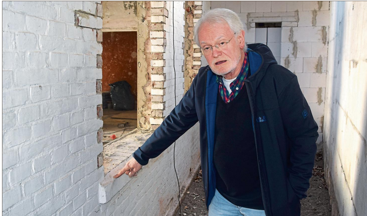
Volker Landig bei einer Begehung der Baustelle Gröschler-Haus im November.
