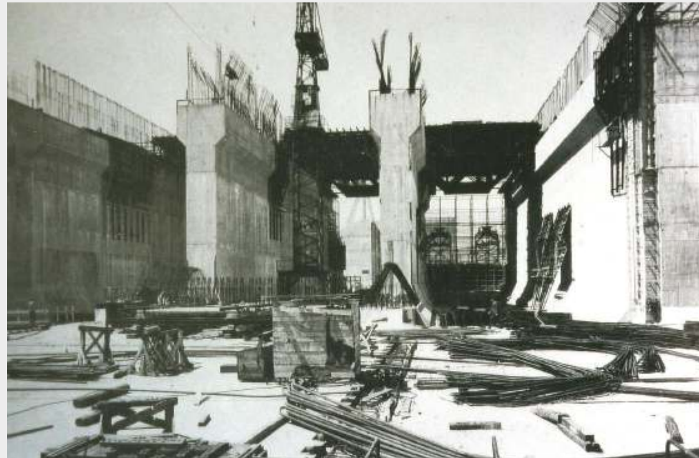
Die Torkammern der Seeschleuse der 4. Einfahrt, 30. Mai 1939 (Sammlung Sommer)
