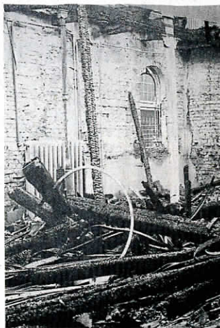
Der Innenraum der Synagoge nach der Zerstörung.
