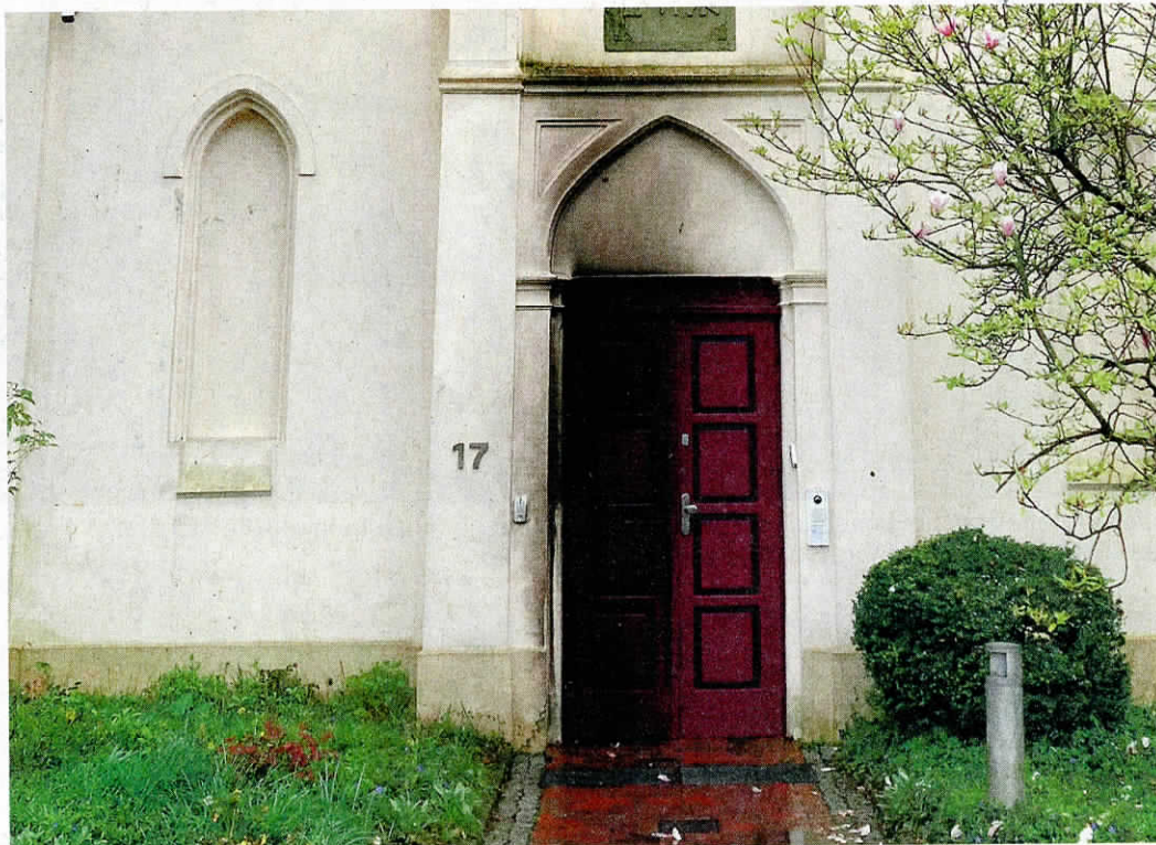
Die Spuren des Anschlags sind deutlich zu sehen: An der Synagoge in Oldenburg hat es im Bereich der Eingangstür gebrannt.
