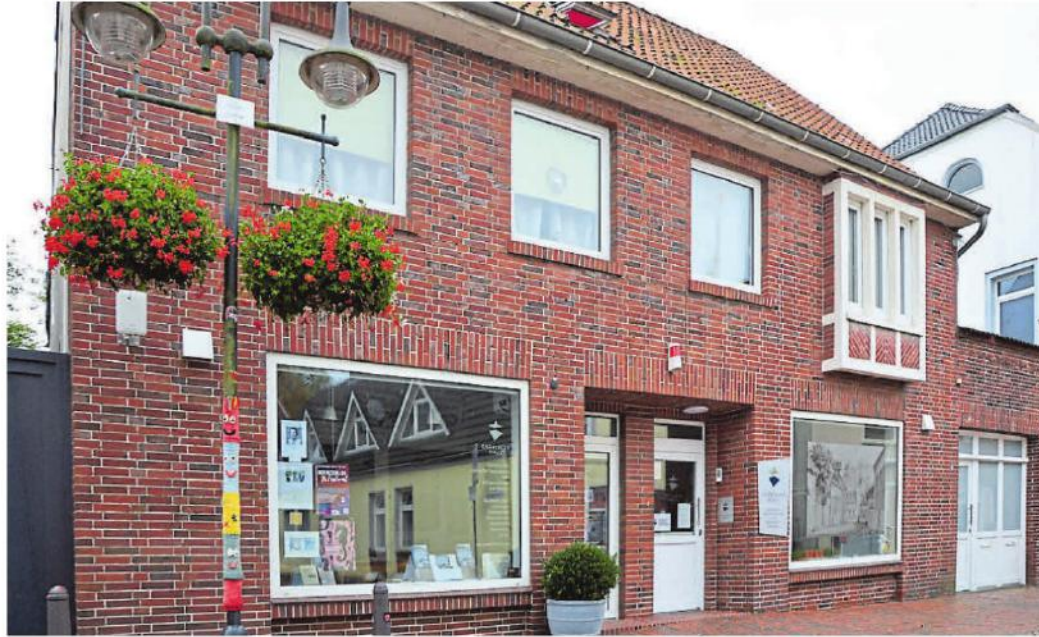
Das Gröschler-Haus in der Großen Wasserpfortstraße in Jever ist als Objekt mittlerweile alarmgesichert.
